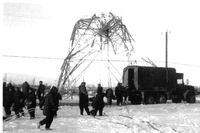
La Troupe opérationnelle devant un des pylônes écrasés sous le poids de la glace.
