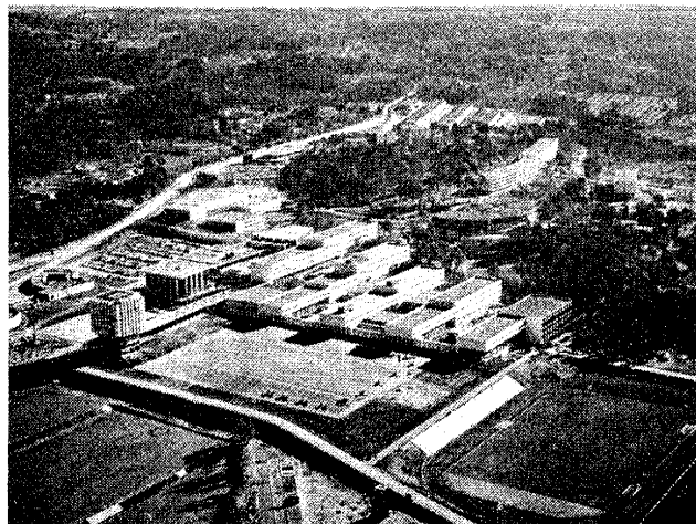
Vue aérienne de l'Ecole.
